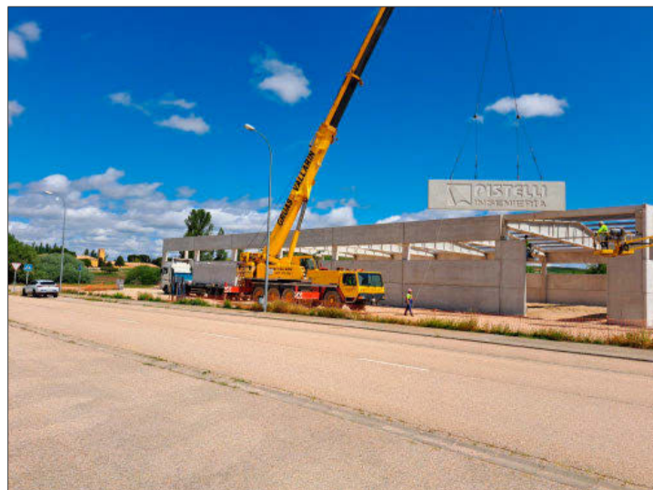
Obras de la planta de Pistelli. HDS
